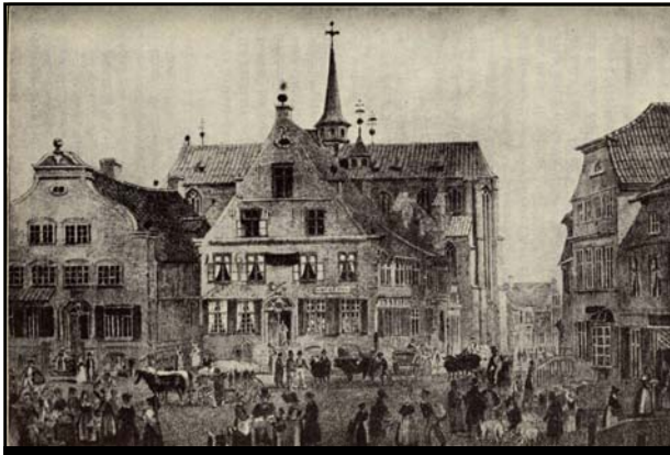
TORVET 8, SCHUMACHERNES GÅRD I HADERSLEV, VINKELDER OG POSTHUS 1649-1705. Huset som endnu eksisterer, er opført 1640 men nu med en helt ombygget facade fra 1850. Udsnit af litografi af W Heuer, 1844
